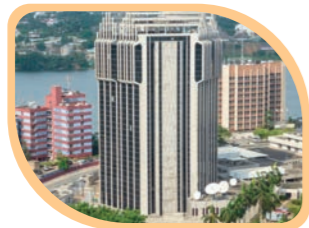
Immeuble BCEAO Abidjan, Côte d'Ivoire
