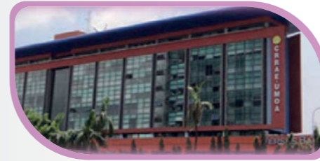
Immeuble CRRAE - UMOA Abidjan, Côte d'Ivoire
